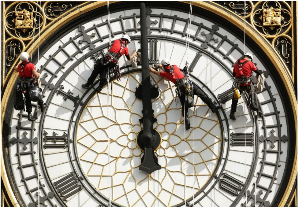
Reparaturarbeiten an der Uhr des Glockenturms „Big Ben“, Westminster, London
